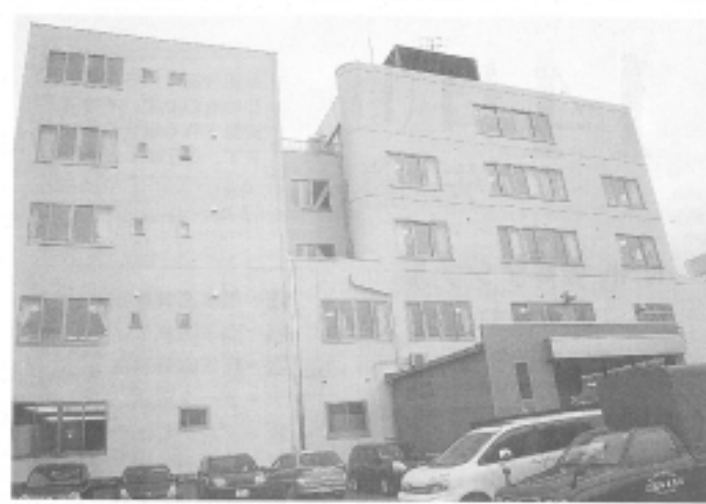
改修、増築工事が完了した西澤病院
