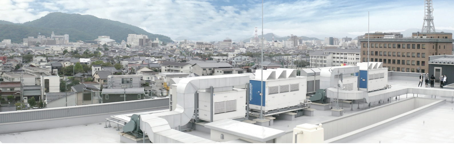
校舎屋上に設置されたモイストプロセッサ2台。グラウンド側の機械はエアコンの室外機。
